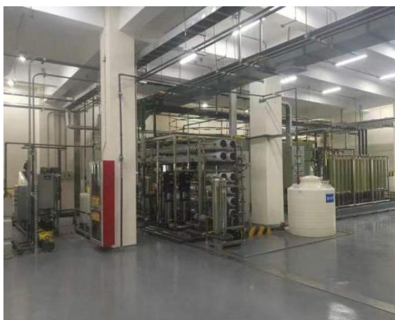
图 16 反渗透及碟管式反渗透系统
