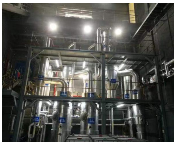
图 17 三效蒸发器系统
